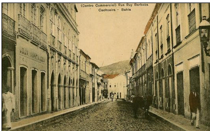
Rua de Entrepontes, atualmente rua Ruy Barbosa
