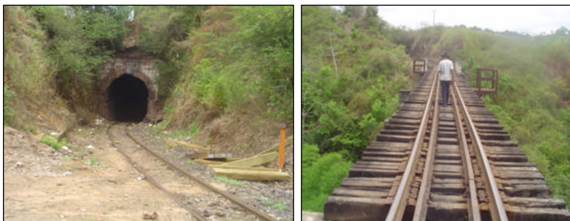
Túnel e viaduto ferroviário construídos na década de 1870 nas terras de Belchior Rodrigues Moura. Sob o viaduto, o local onde existiria o culto a Azonsur.
